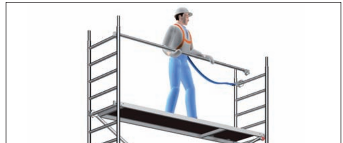
Bild 3: Sichere Montage der Rückenlehnen mit PSA
