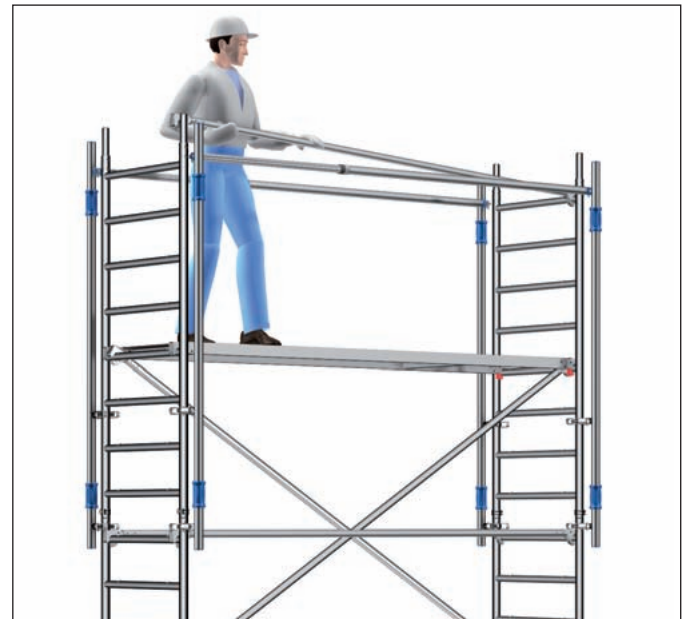
Bild 6: Sichere Montage der Rückenlehnen mit MSG
